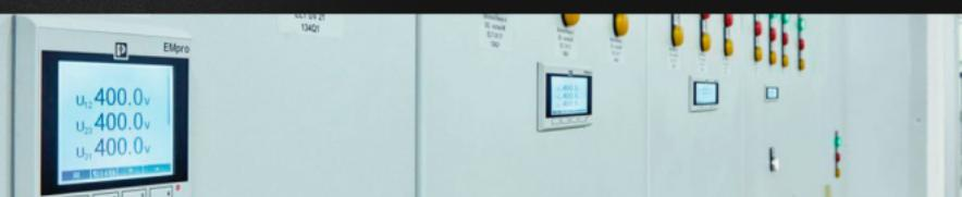
**EMpro:** Registran y comunican los datos de consumo energético de la planta, permitiendo un control preciso del uso de energía en cada fase del proceso. Su integración web facilita el monitoreo remoto, la optimización del consumo y la detección temprana de anomalías, impulsando una gestión energética más eficiente y sostenible.
